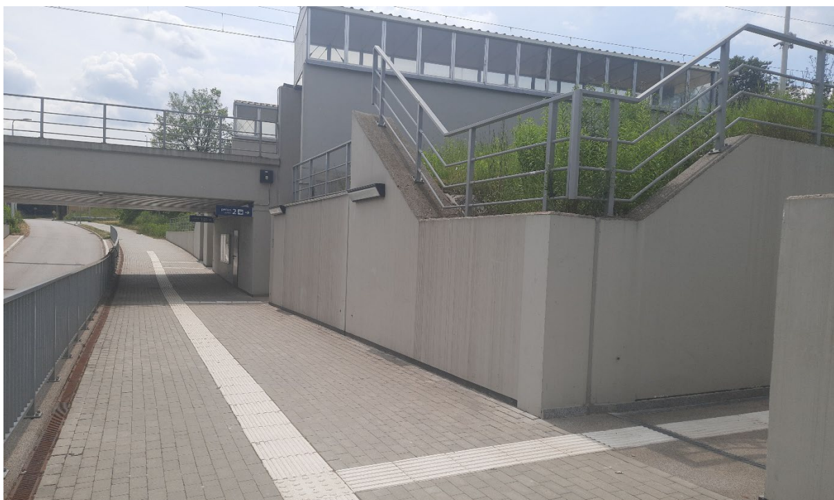
Zdjęcie 49. Przejazd i przejście pod peronami
