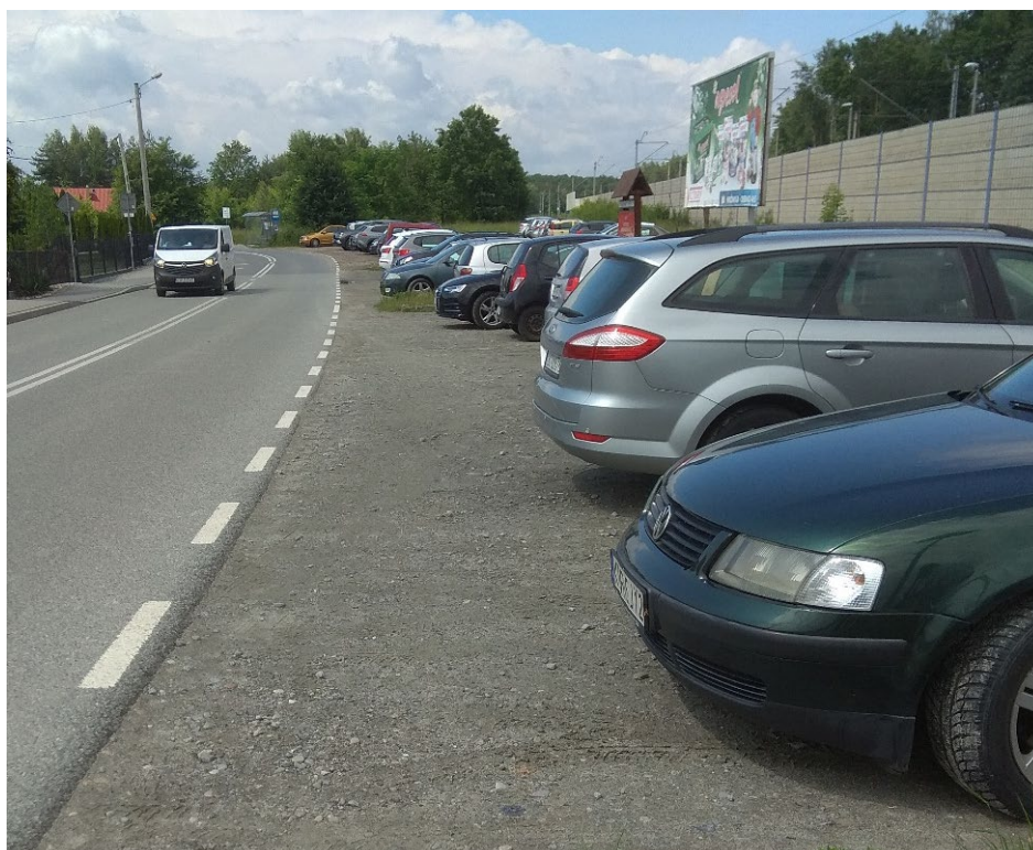
Zdjęcie 129. Miejsca parkingowe wzdłuż ekranów akustycznych przy peronie w Sterkowcu
