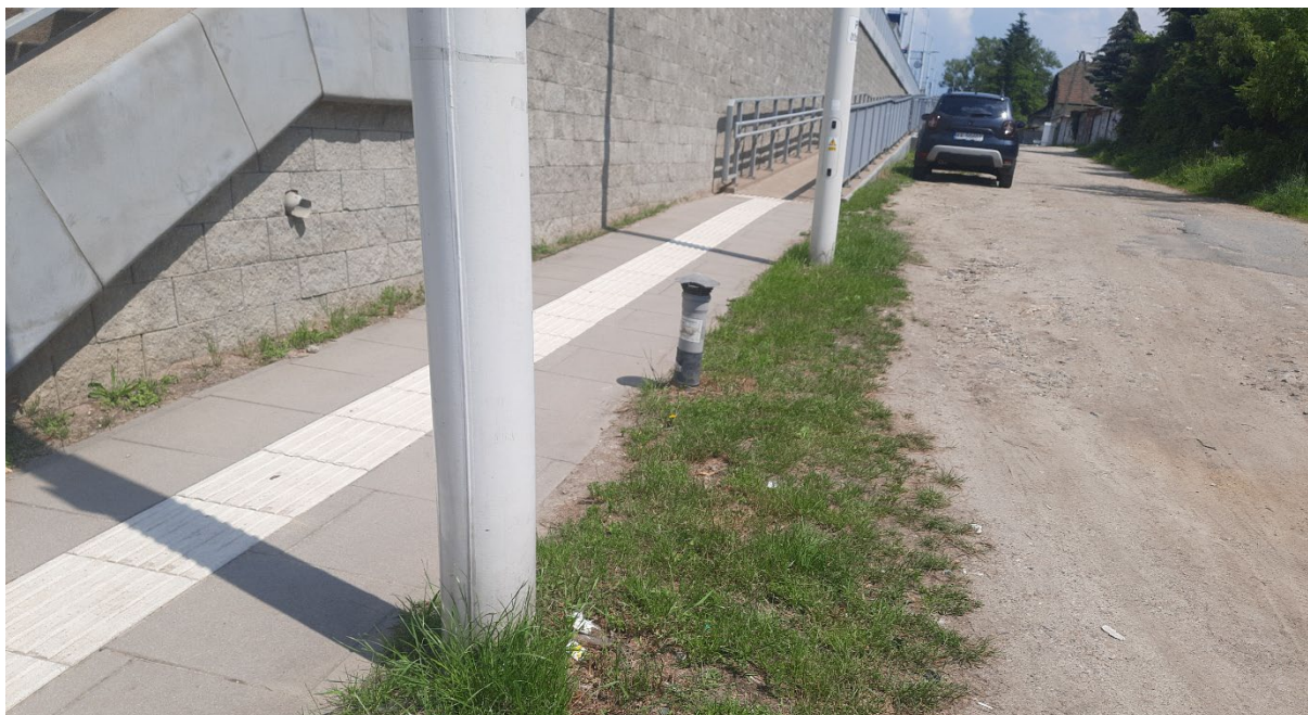
Zdjęcie 26. Miejsca wzdłuż peronu, na których stoją zaparkowane samochody
