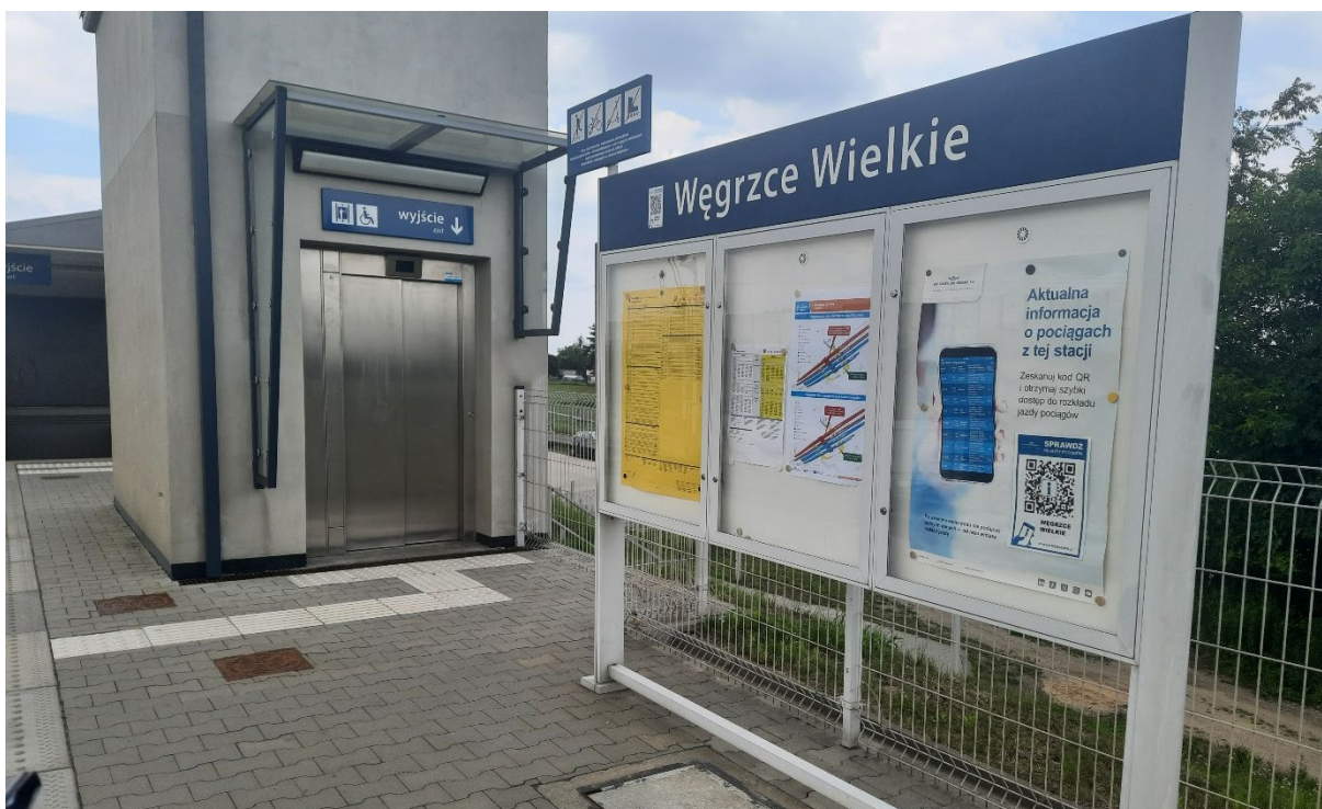
Zdjęcie 54. Winda prowadząca do przejścia podziemnego
