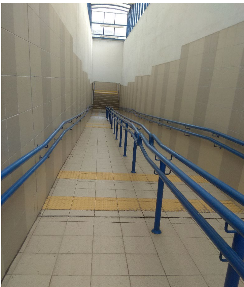
Zdjęcie 135. Pochylnia do przejścia podziemnego na przystanku kolejowym w Biadolinach
