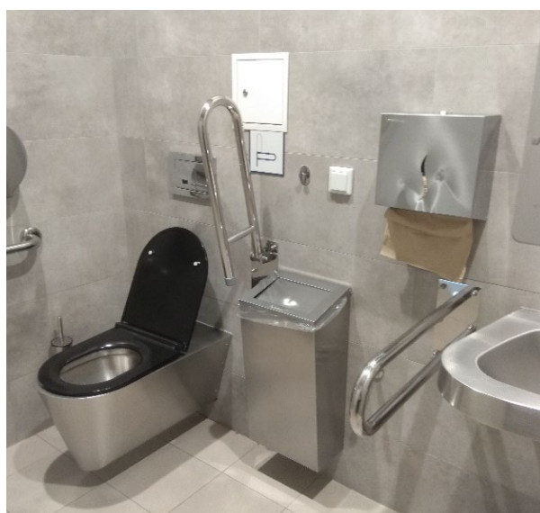
Zdjęcie 134. Toaleta na dworcu w Biadolinach
