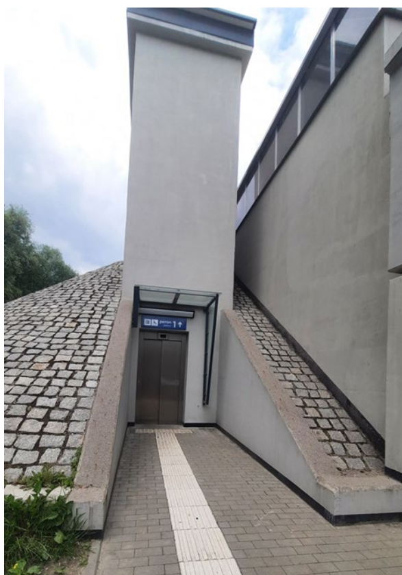
Zdjęcie 41. Winda oraz schody prowadzące do przejścia podziemnego na stacji Kraków Złocień
