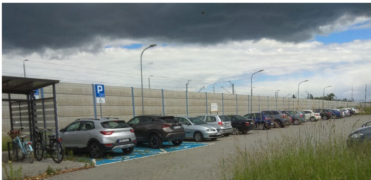
Zdjęcie 137. Miejsca parkingowe wzdłuż ekranów akustycznych przy peronie w Biadolinach
