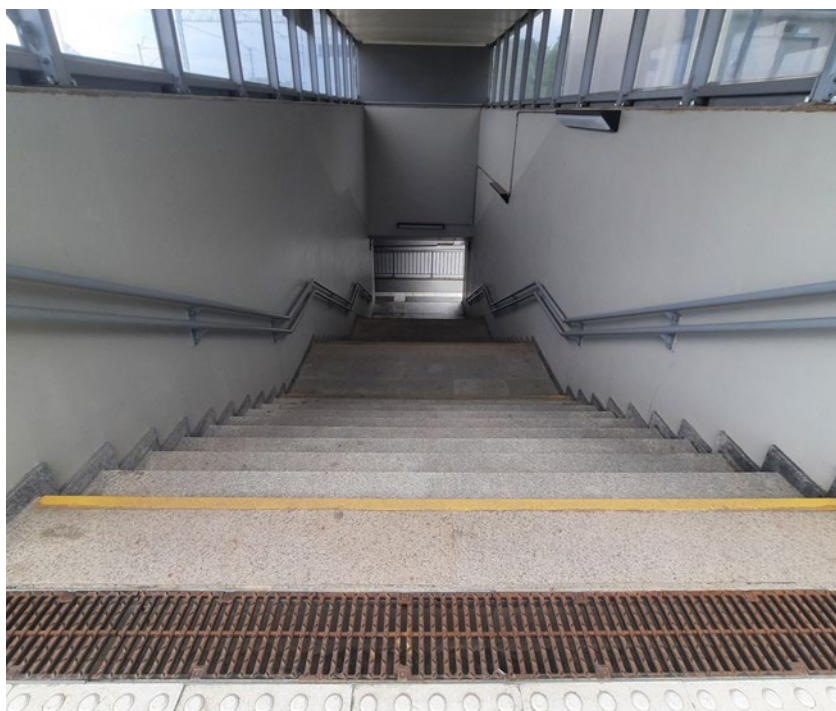
Zdjęcie 40. Wejście na peron na stacji Kraków Złocień
