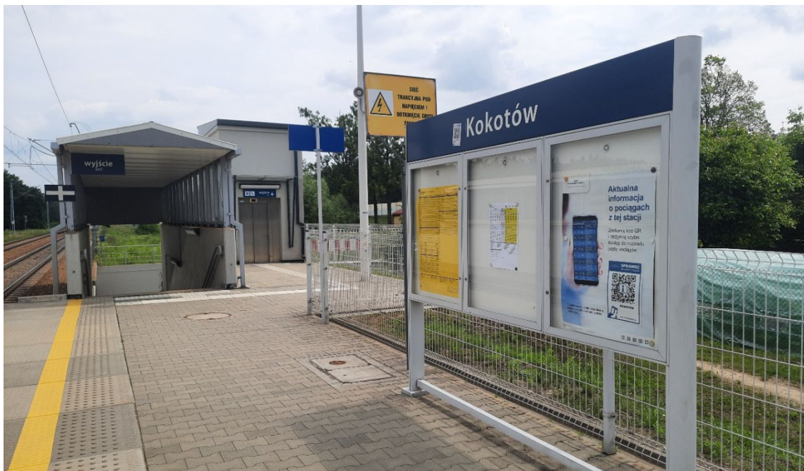
Zdjęcie 47. Winda oraz schody prowadzące do przejścia podziemnego
