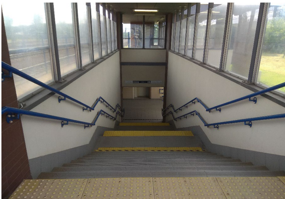
Zdjęcie 148. Zejście do przejścia podziemnego przy przystanku Tarnów Mościce
