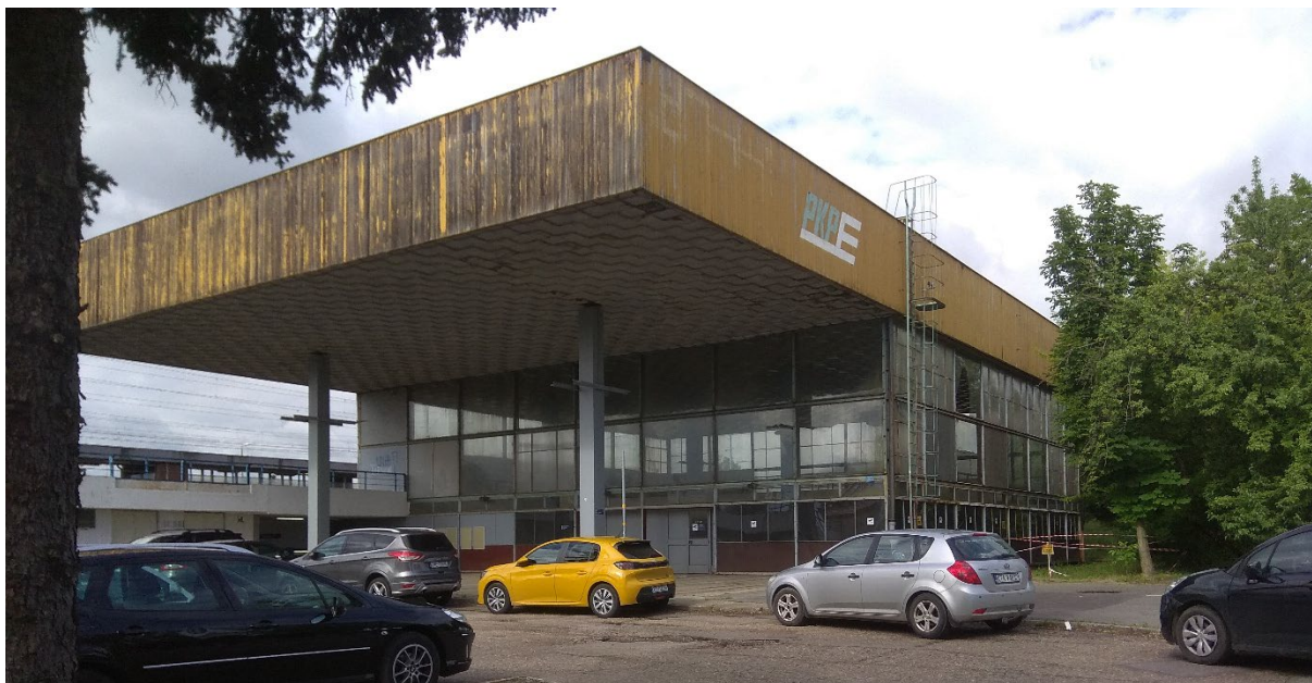
Zdjęcie 147. Budynek dawnego dworca kolejowego Tarnów Mościce
