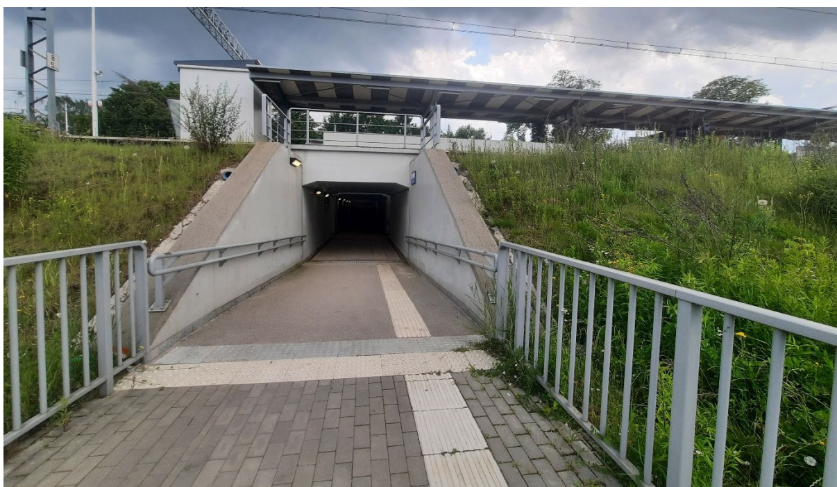
Zdjęcie 35. Przeście podziemne pod peronami 1 i 2
