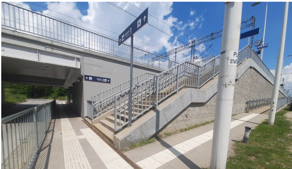
Zdjęcie 25. Przejście podziemne prowadzone wzdłuż pasa jezdni – wejście na peron 1 – schody oraz pochylnia
